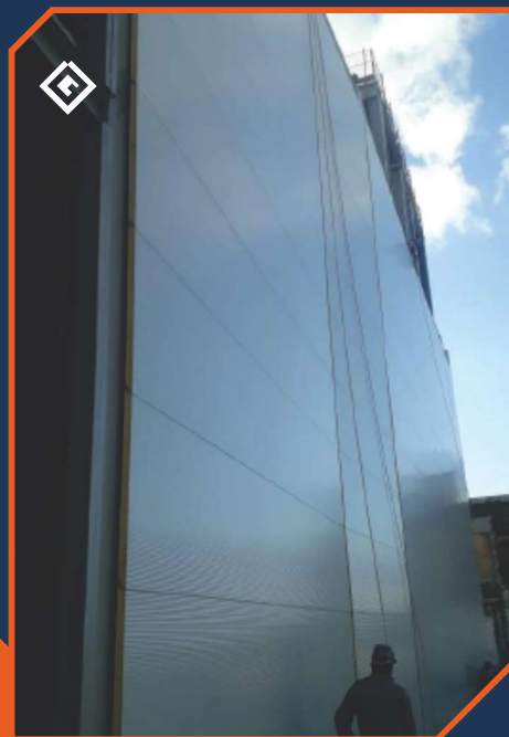
PAREDE CORTA FOGO
